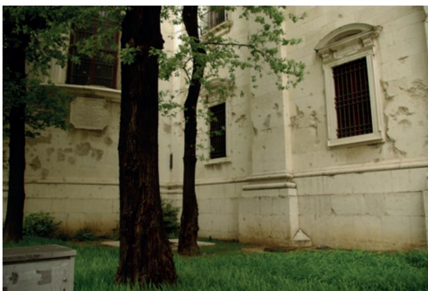
Danni causati dai bombardamenti sui marmi del Duomo Nuovo
