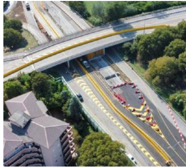
Una volta messa in sicurezza la struttura è stata parzialmente riaperta
