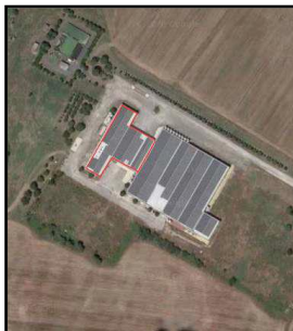
Porzione di impianto su capannone industriale
