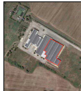
Porzione di impianto su capannone industriale
