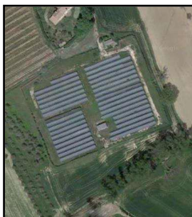
Impianto su terreno
