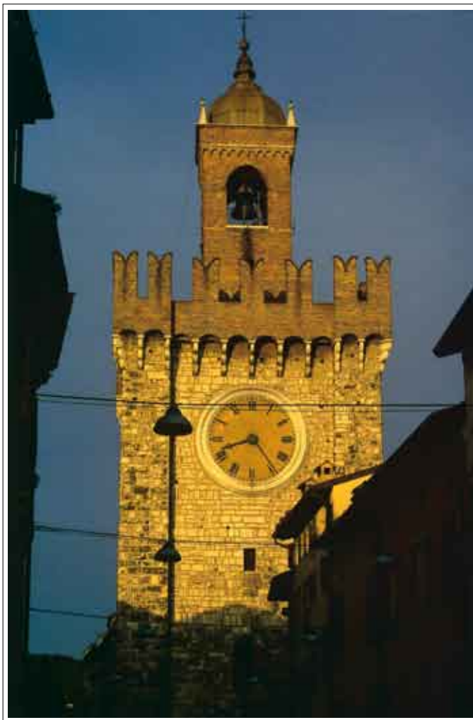
Torre della Pallata 27 maggio 2009 ore 20.16
